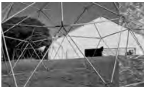
Installation des tentes
